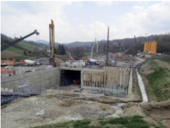
Superstrada Pedemontana Veneta
